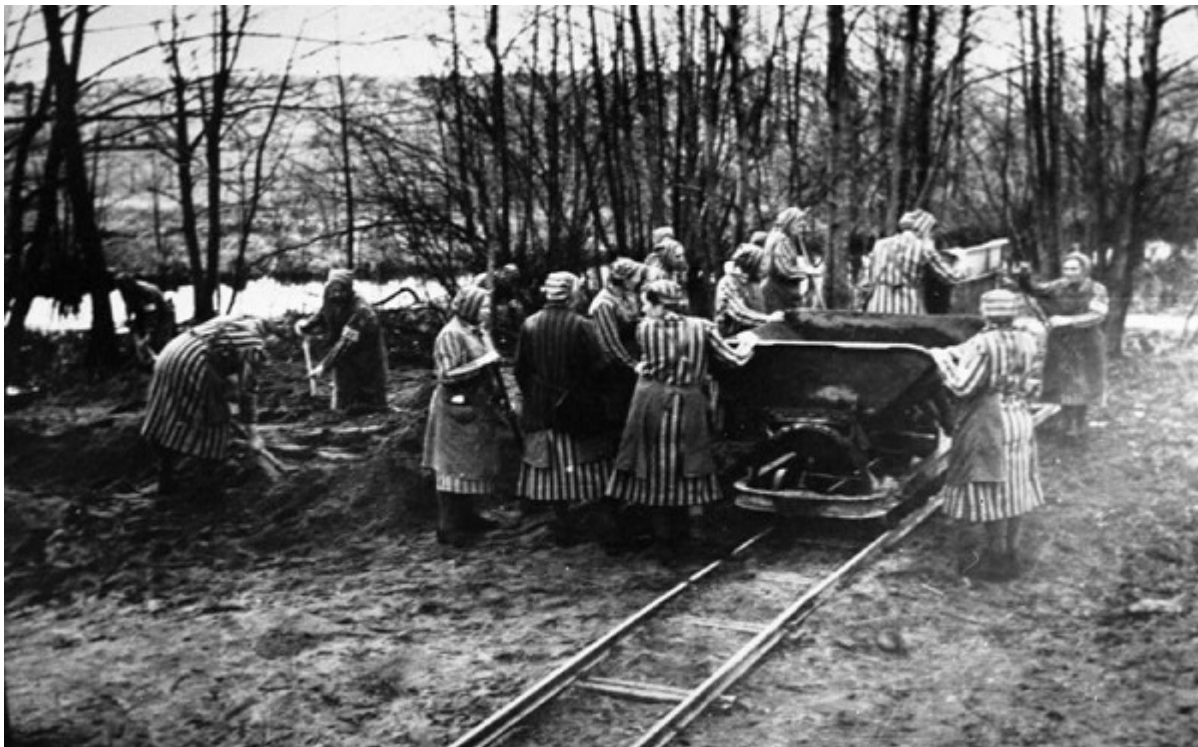
На строительстве Равенсбрюка
