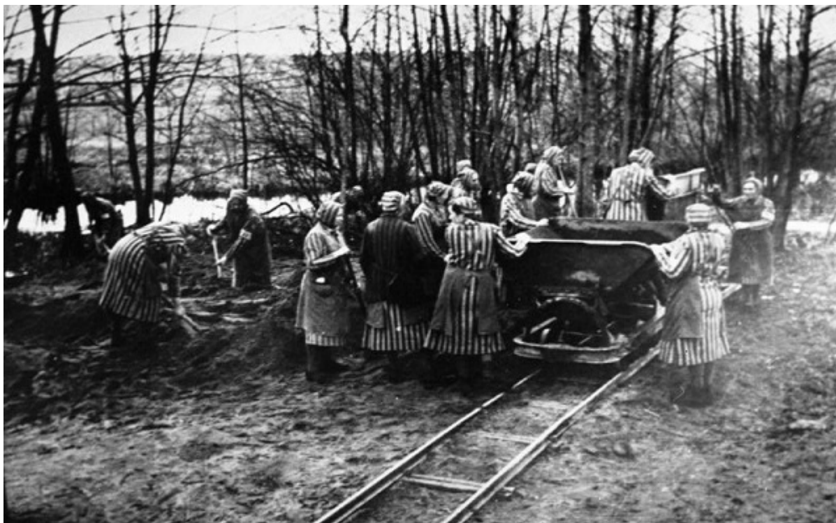
На строительстве Равенсбрюка
